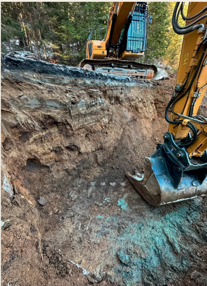
Baggerarbeiten im Zuge der Straßensanierung hinterm Pichlerhof
