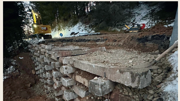
Die neu errichtete Krainerwand stützt die Straße
