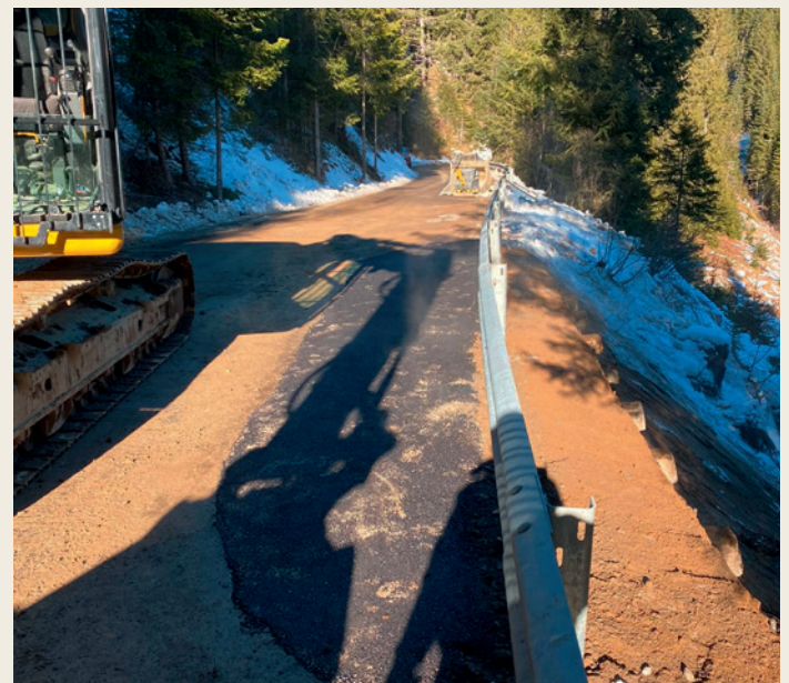
Die Straßenschäden hinterm Pichlerhof wurden beseitigt
